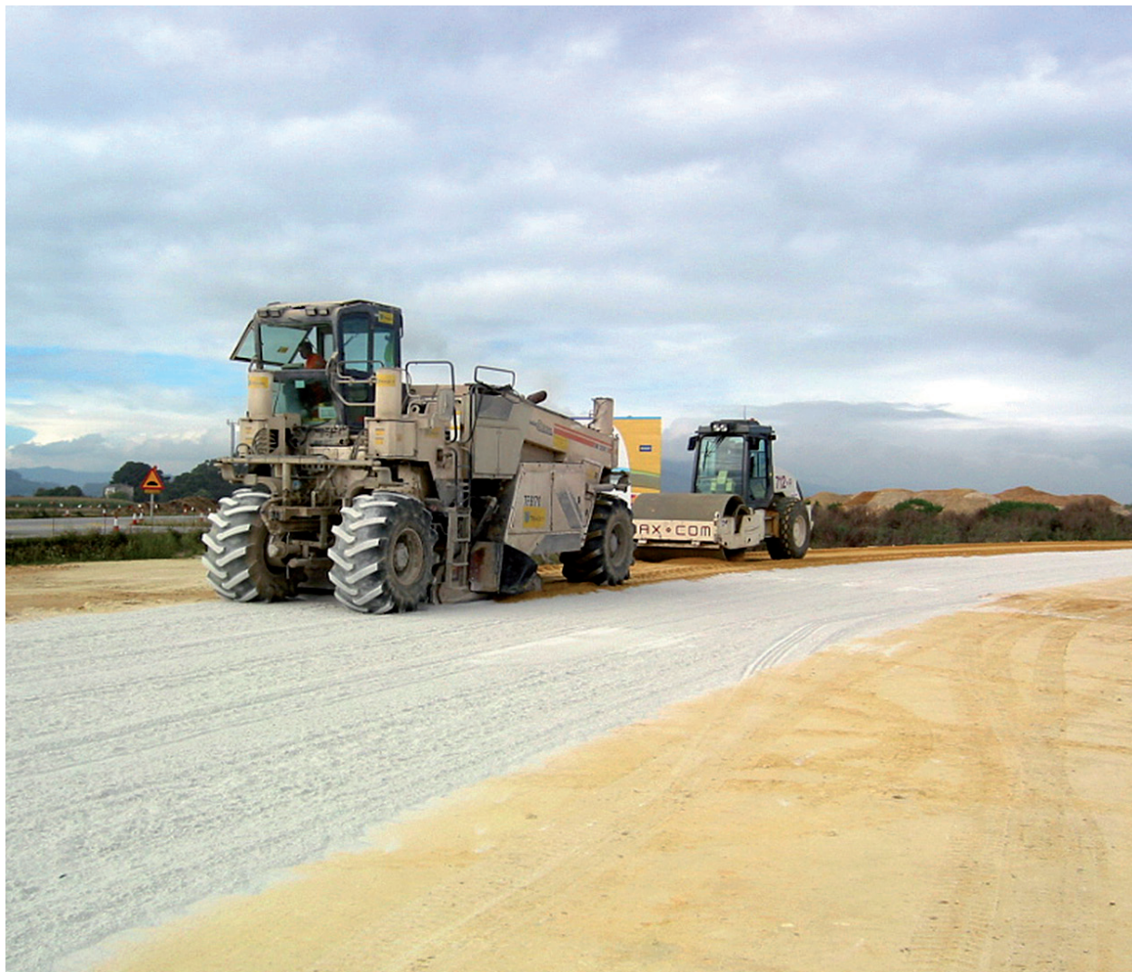
Autovía del Cantábrico. Tramo Barres-Ribadeo. Asturias.
